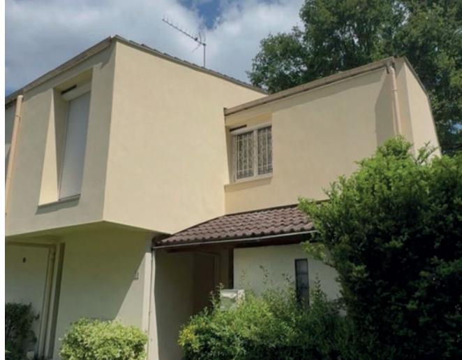
Maison de la Noisienne Stéphanie Pieri qui a bénéficié de gros travaux d'isolation.
