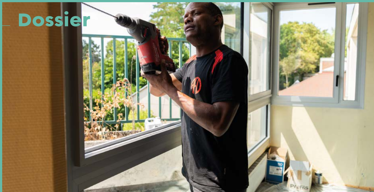
Remplacement des fenêtres à l'élémentaire Van Gogh pour une meilleure isolation phonique et thermique.
