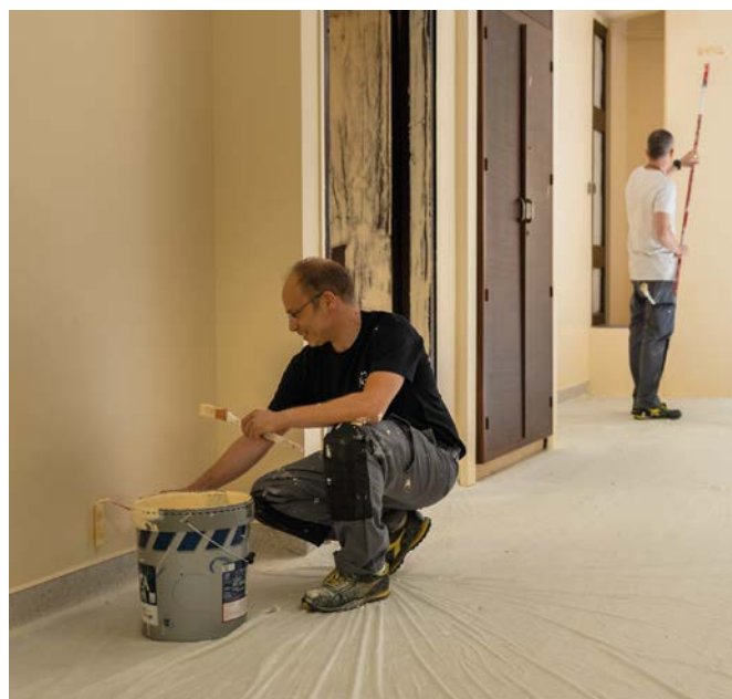
Peinture en régie des couloirs du rez-de-chaussée de l'élémentaire des Hauts-Bâtons.
