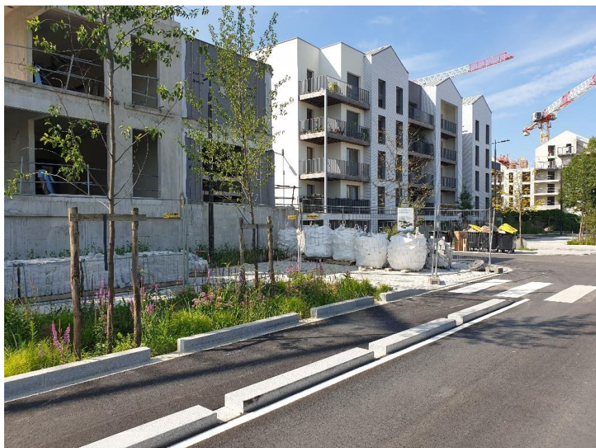
Figure 10 : Noues d'infiltration à l'Ecoquartier Ile de la Marne
