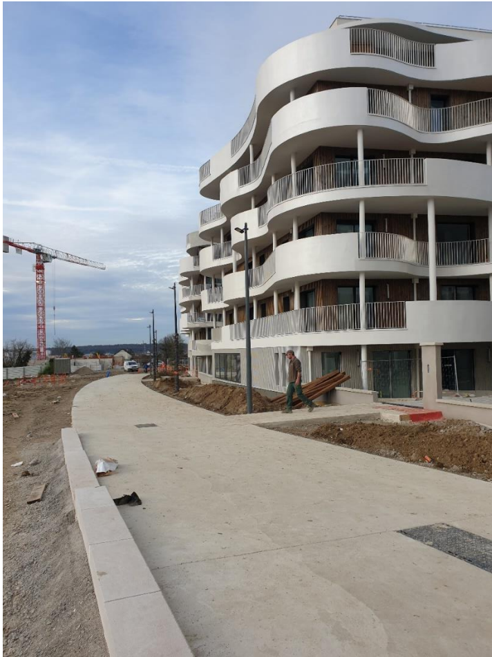
Figure 12 : Lot M1 et 1ère phase de l'allée courbe (béton bas carbone)
